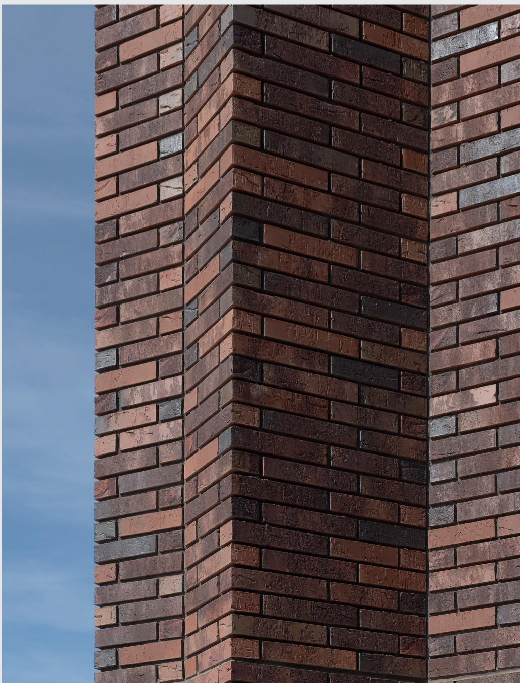
Фрагмент фасада Sydney Prime, кирпичная кладка из «Брюне» и «Тромсё»
