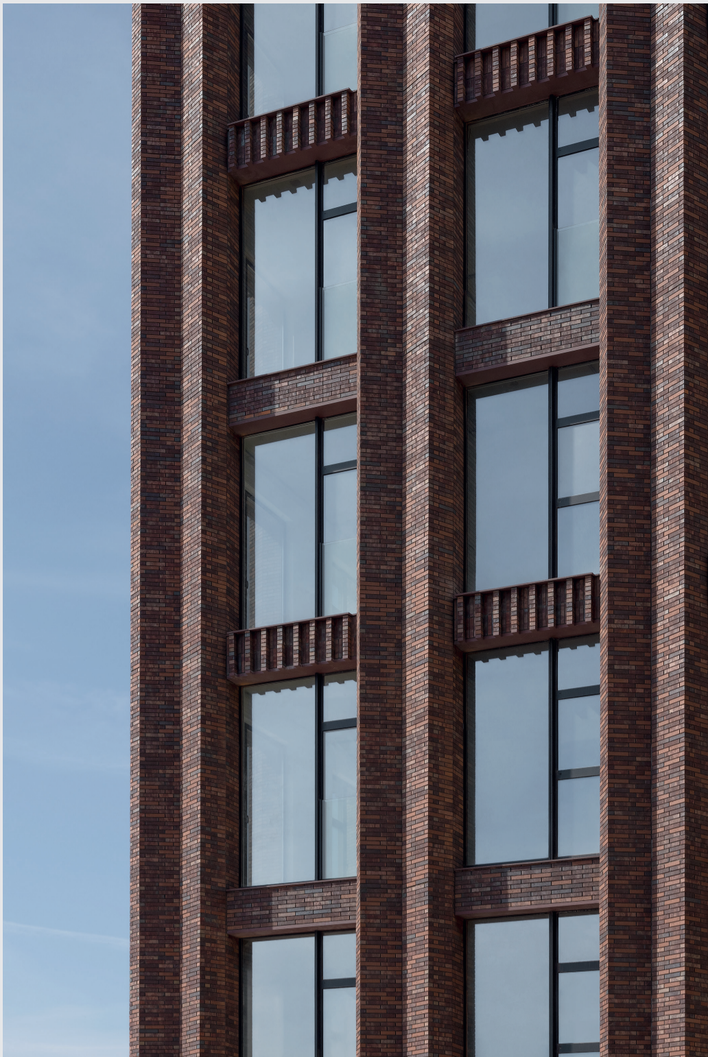
Фрагмент фасада Sydney Prime, кирпичная кладка из «Брюне» и «Тромсё»
